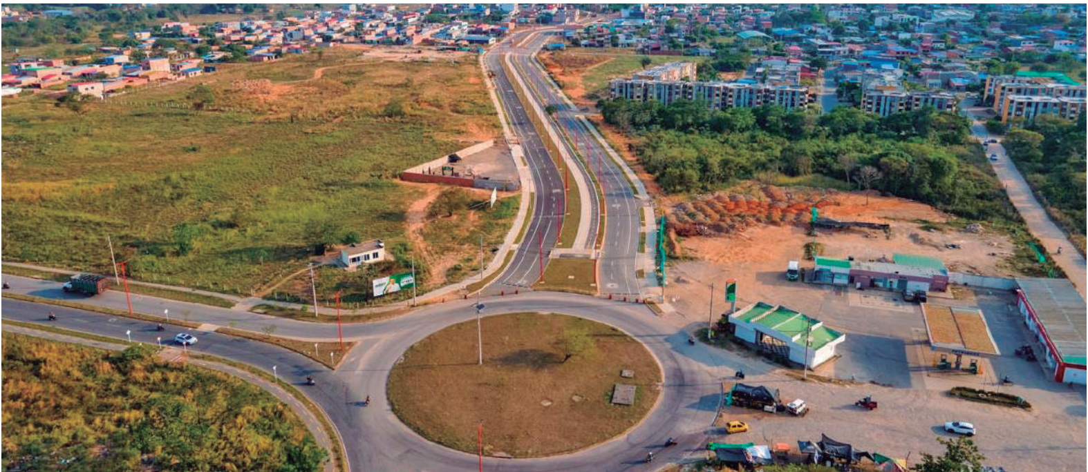
Construcción de la Avenida Primera en Yopal.
