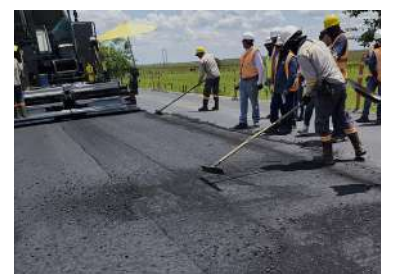
Repavimentación de vías.
